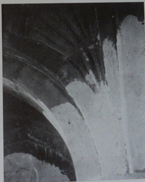
PENDENTIF SUD OUEST
